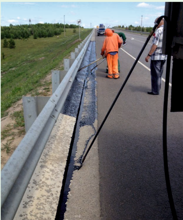
Обработка бетона ПАБ «Дорсан»
